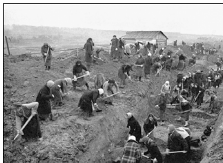
На строительстве оборонительного рубежа
